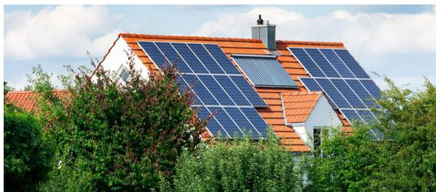
Auf den Seiten befinden sich Photovoltaikmodule, mittig ein Solarkollektor (Quelle: dachgold.at)
